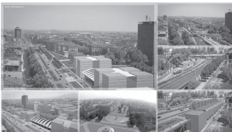
Cantieri del Passante ferroviario
